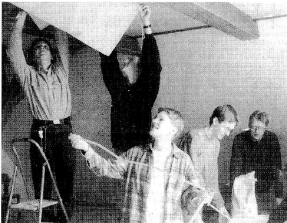
Schülerinnen und Schüler der Bau-AG bei der Arbeit. Einmal in der Woche treffen sie sich, um auf dem Dachboden des Domgymnasiums einen Raum auszubauen. Er soll später von der Marionetten-AG als Übungsraum für ihre Auftritte genutzt werden.
